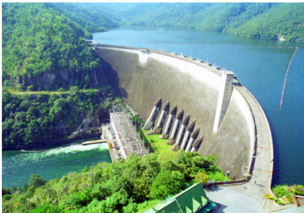
โรงไฟฟ้าพลังน้ำ เขื่อนภูมิพล จังหวัดตาก (ภาพจากการไฟฟ้าฝ่ายผลิตแห่งประเทศไทย)
